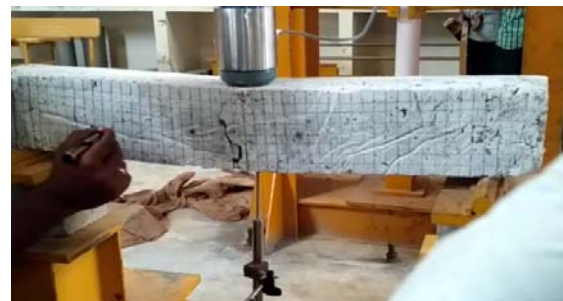
Fig:5 Crack Pattern
